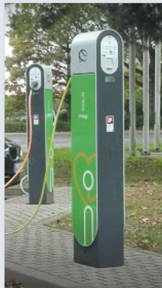
Normalladesäule Wechselstrom (AC) Ladeleistung bis 22 kW
